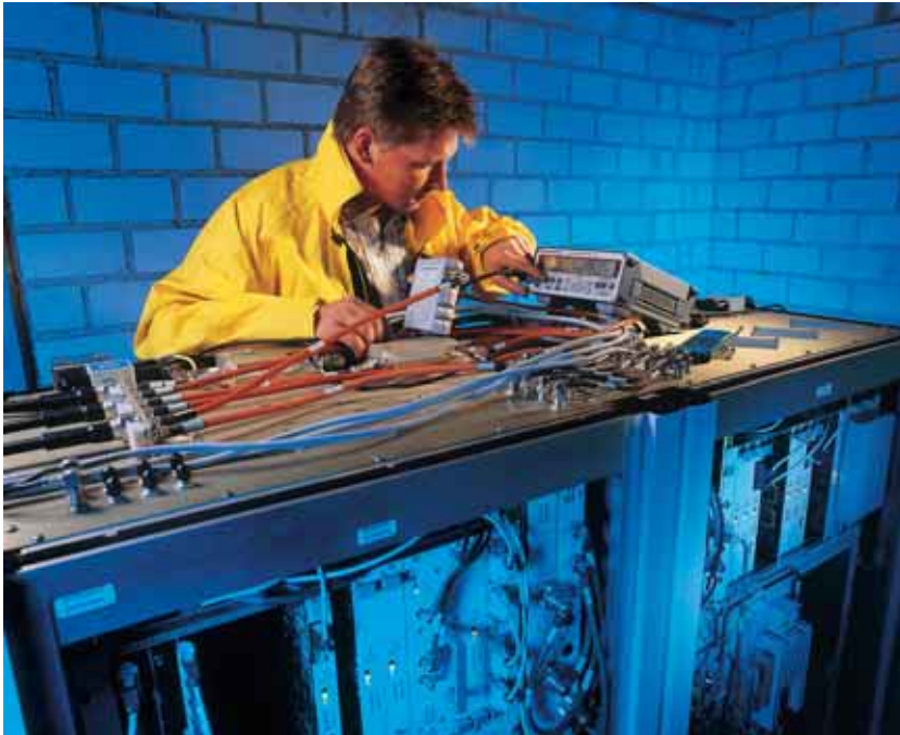
R&S®NRT bei der Installation einer Mobilfunk-Basisstation
